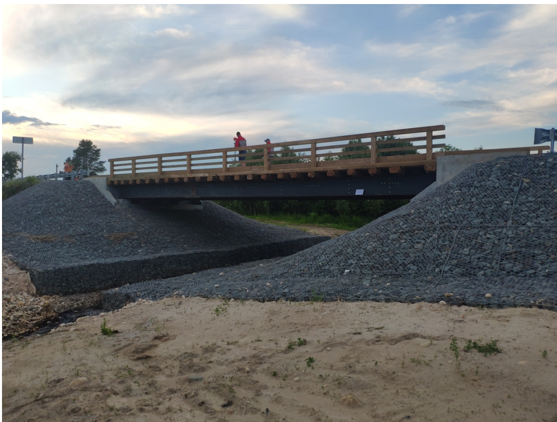
Рисунок 9. Общий вид мостового перехода от опоры №2 справа
