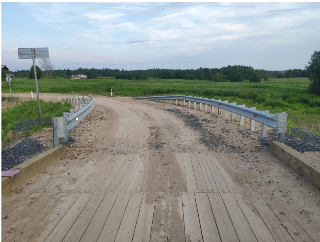
Рисунок 4 – Вид на подход со стороны опоры №4
