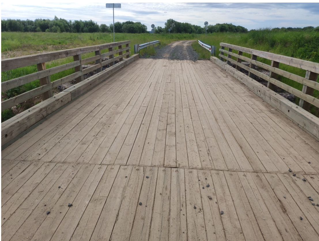
Рисунок 17. Общий вид проезжей части от опоры №1
