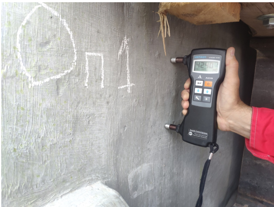
Рисунок 25 – Измерение скорости методом УЗК на шкафной стенке
