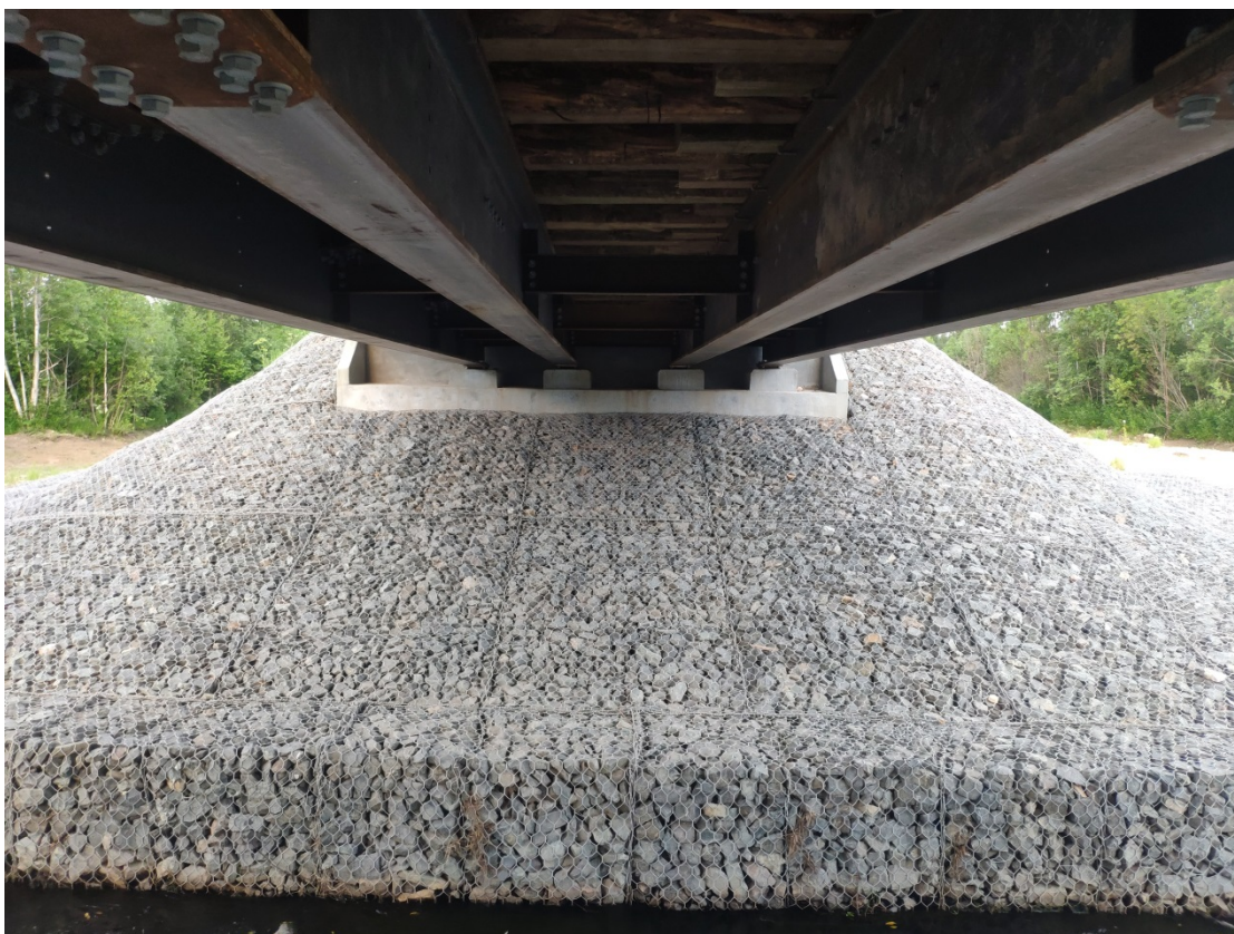
Рисунок 14. Общий вид опоры №2 и пролетного строения
