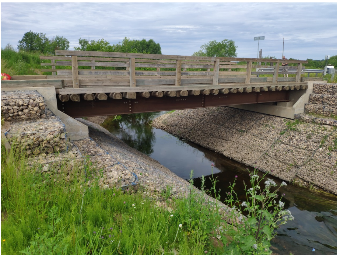
Рисунок 16. Общий вид мостового перехода от опоры №2 слева
