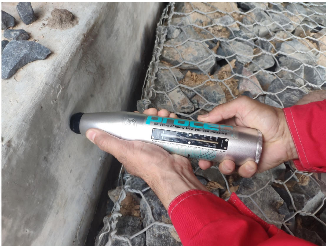
Рисунок 26 – Измерение прочности бетона методом отскока
