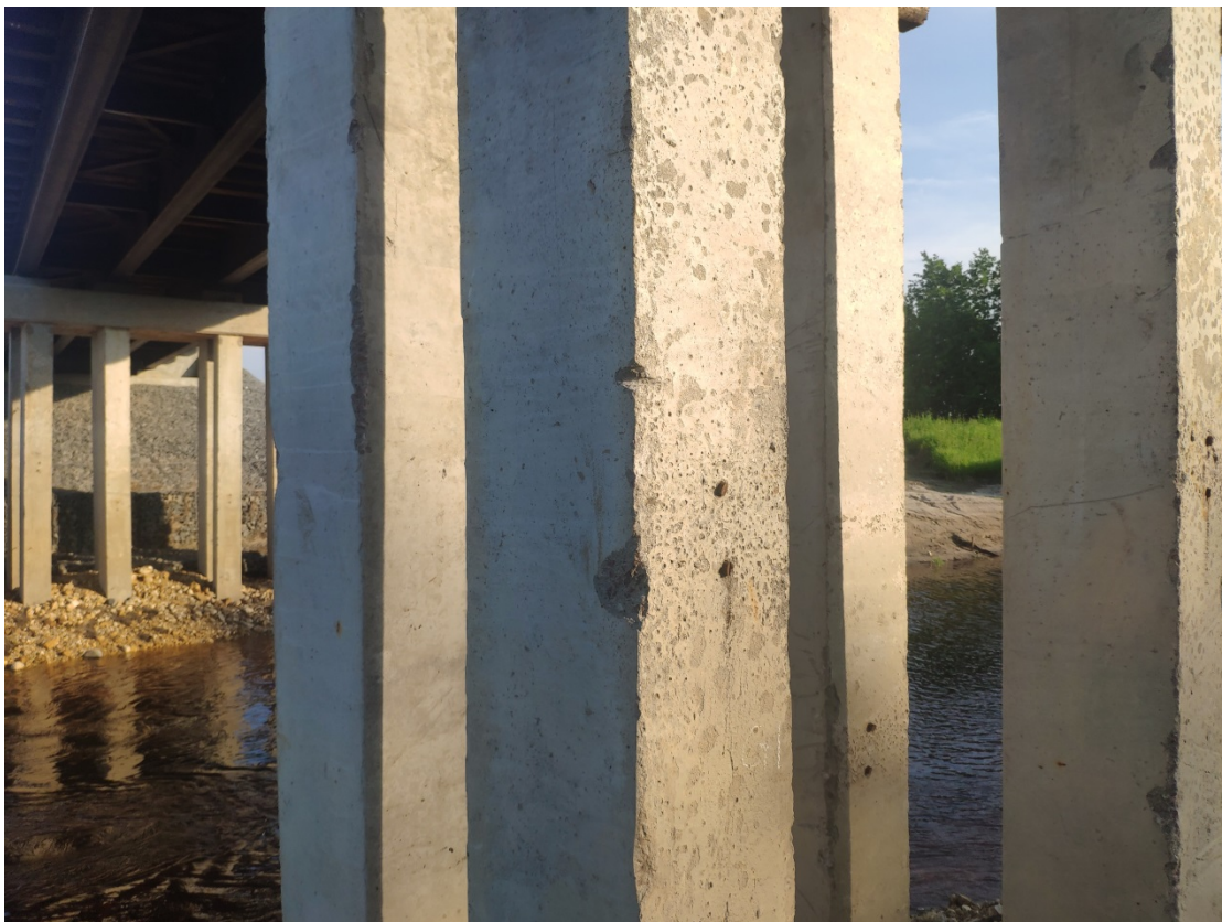
Рисунок Б7 – Не заделанные поверхности, в местах обрезки строповочных петель стоек опоры №2
