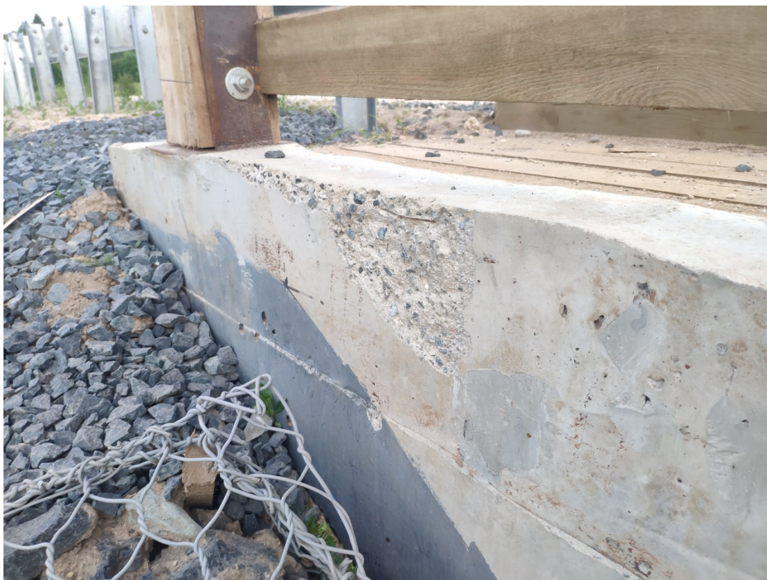
Рисунок Б19 – Механический скол
