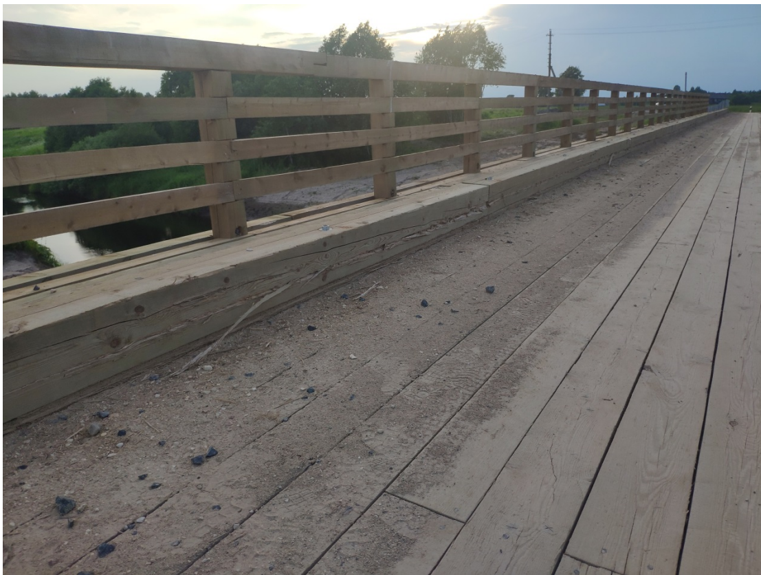
Рисунок Б1 – Механический скол на правом колесоотбойном брус
