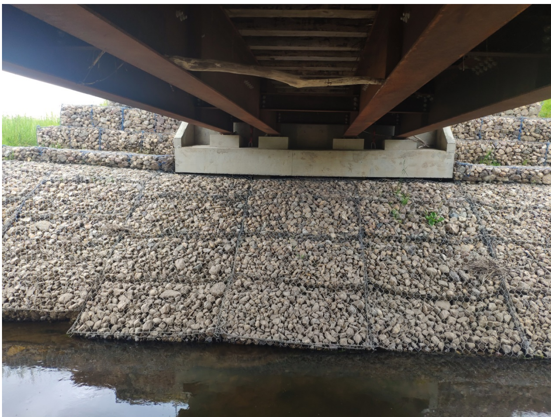
Рисунок 18. Общий вид опоры №2 и пролетного строения
