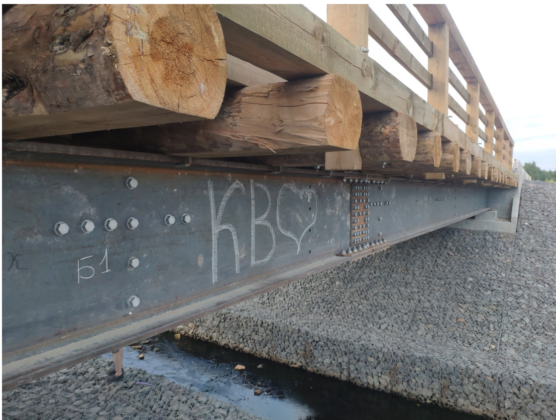
Рисунок 15. Общий вид пролетного строения от Б1 и деревянного настила
