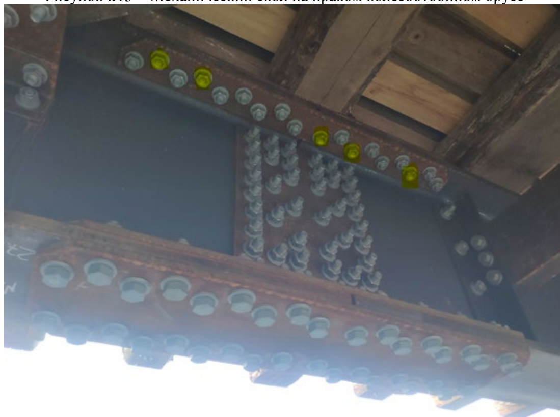
Рисунок Б14 – Недостаточное количество витков в болтовых соединениях
