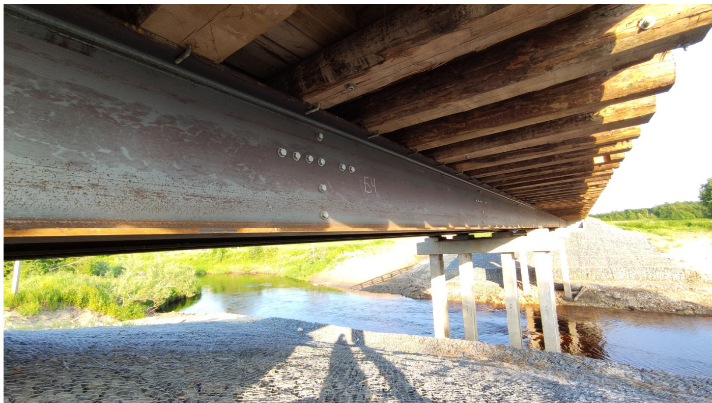
Рисунок 8 – Общий вид на пролетное строение и консоль тротура
