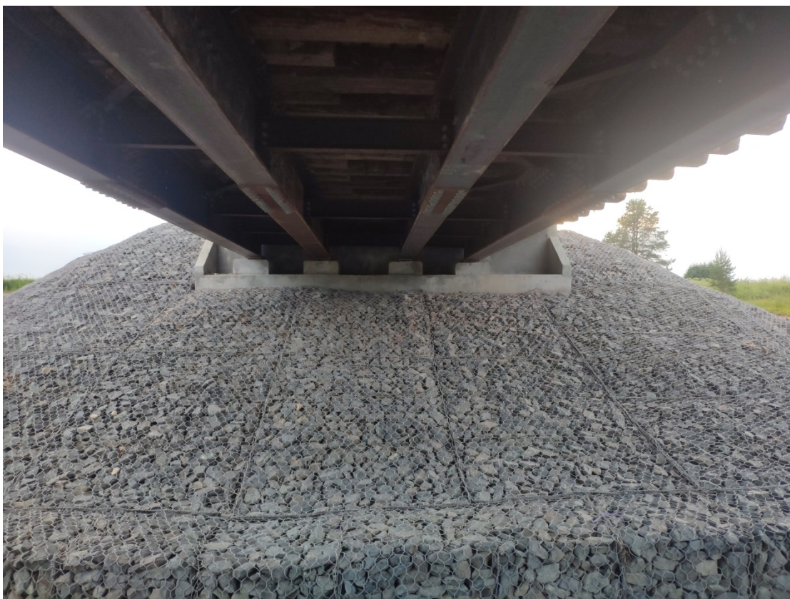
Рисунок 13. Общий вид опоры №1 и пролетного строения
