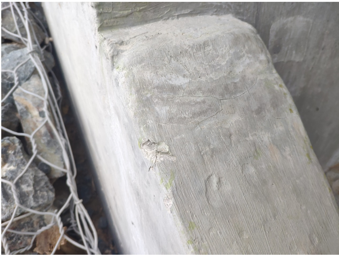
Рисунок Б17 – Механический скол и сетка технологических трещин
