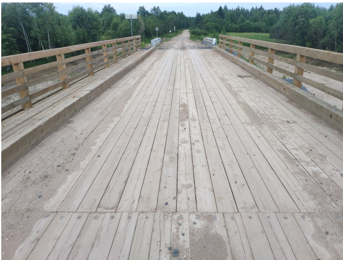
Рисунок 10. Общий вид проезжей части и тротуара от опоры №1
