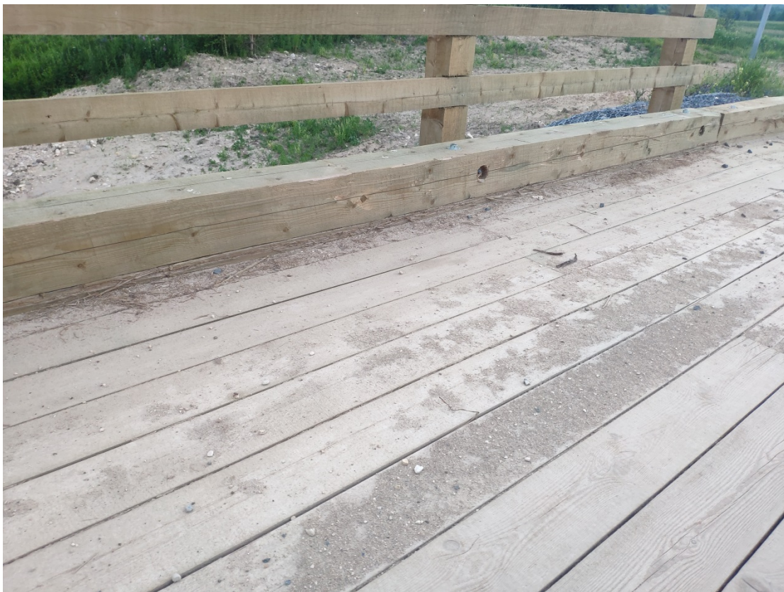
Рисунок Б13 – Механический скол на правом колесоотбойном брус
