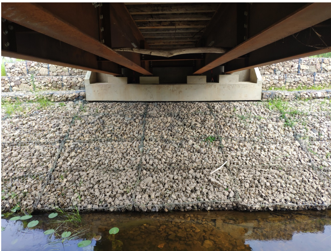
Рисунок 19. Общий вид опоры №1 и пролетного строения
