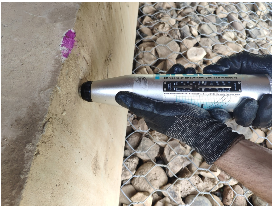
Рисунок 30 – Измерение прочности бетона методом отскока
