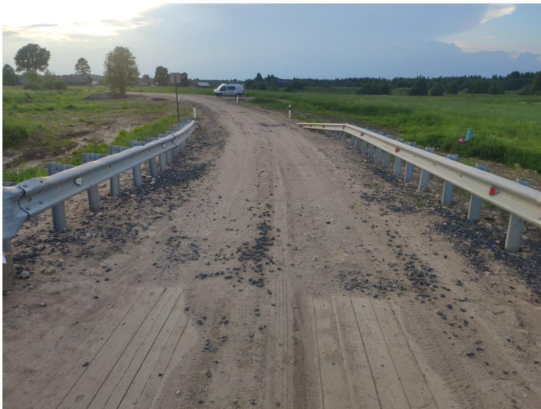
Рисунок 3 – Вид на подход со стороны опоры №1
