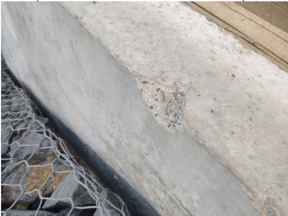
Рисунок Б18 – Механический скол
