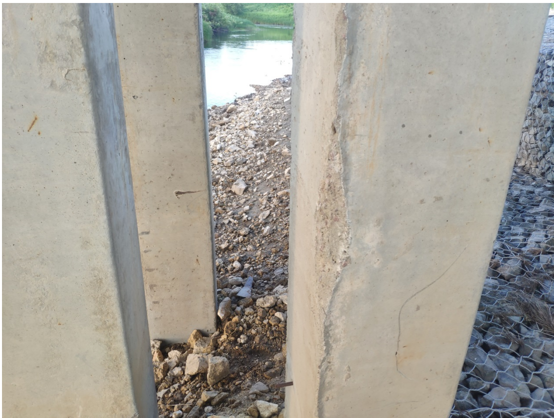
Рисунок Б6 – Механический скол стоек опоры №3
