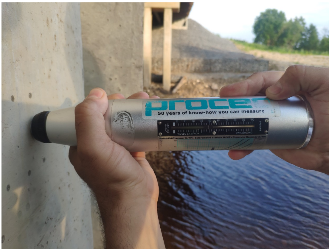
Рисунок 21 – Измерение прочности бетона методом отскока
