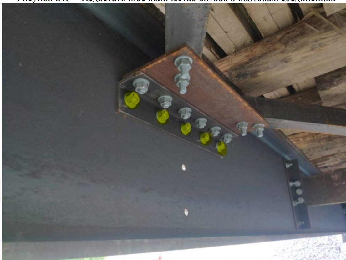
Рисунок Б16 – Недостаточное количество витков в болтовых соединениях
