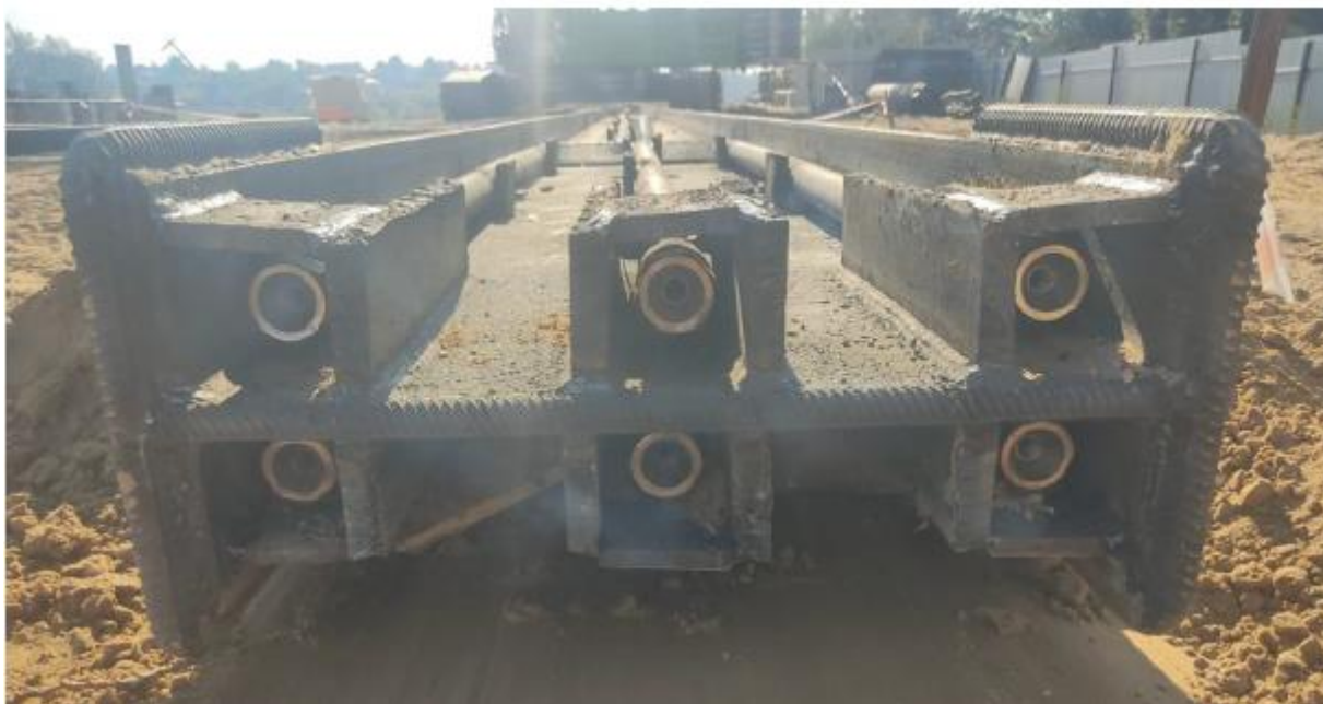
Рисунок 24 – Расположение форсунок подмыва
